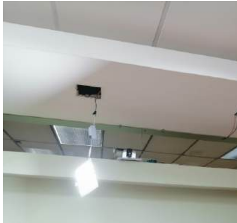
Fotografía 5: Mejoras en sistema eléctrico
