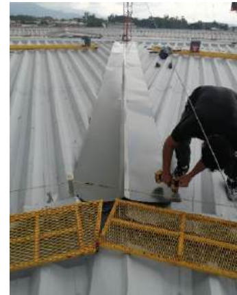
Fotografía 4: Reparación cubierta de techo
