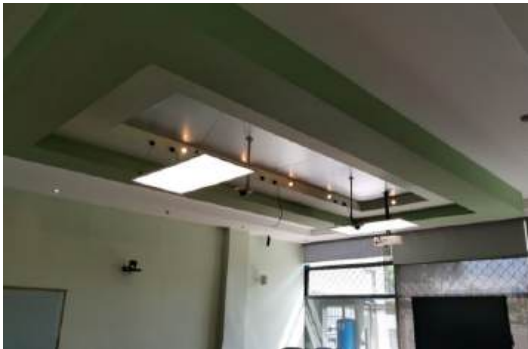
Fotografía 1: Cambio de luminarias Led
