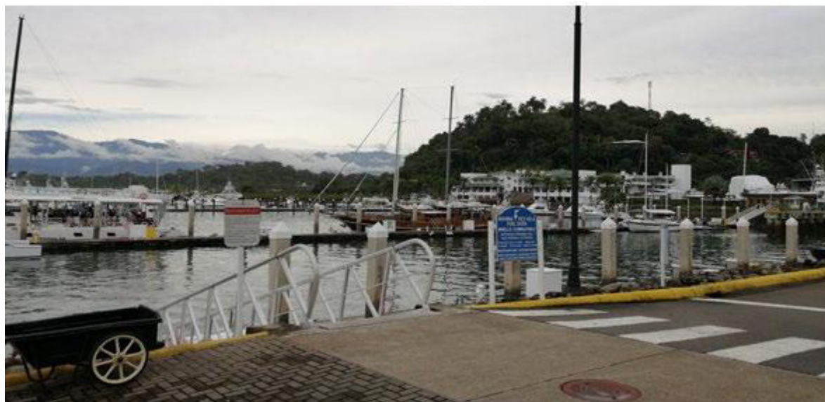
Imagen 2: instalaciones de la segunda etapa de Marina Pez Vela en Quepos de Puntarenas, fuente CIMAT.
