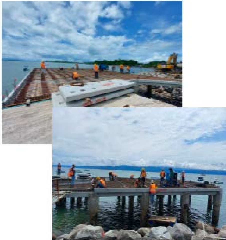
Figura 8. Trabajo en obra, Muelle de Puerto Jiménez. Fuente: MOPT.
